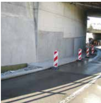
Principe 7, methode 7.2 MasterEmaco gebruikt om door chloride aangetast beton te vervangen.
