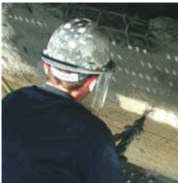
Principe 7, methode 7.1 Wapeningsdekking verhogen met verspuitbare MasterEmaco .
