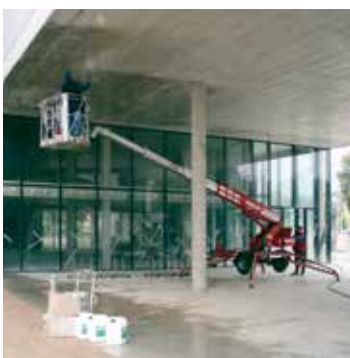
Principe 8, methode 8.1 Waterafstotende behandeling met MasterProtect .
