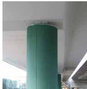
Principe 9, methode 9.1 MasterProtect -coatings rechtstreeks aangebracht op het beton om de onderliggende wapening te beschermen.
