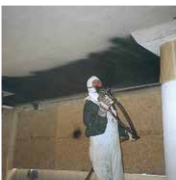
Principe 10, methode 10.1 MasterProtect CP-coatings beschermen gewapend beton zonder bijkomende extra belasting.
